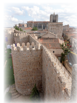
Murallas de Ávila. Detalle.
